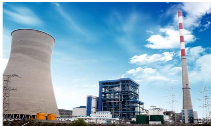
**600MW**超临界CFB(白马)，目前世界规模最大、参数最高的CFB机组
